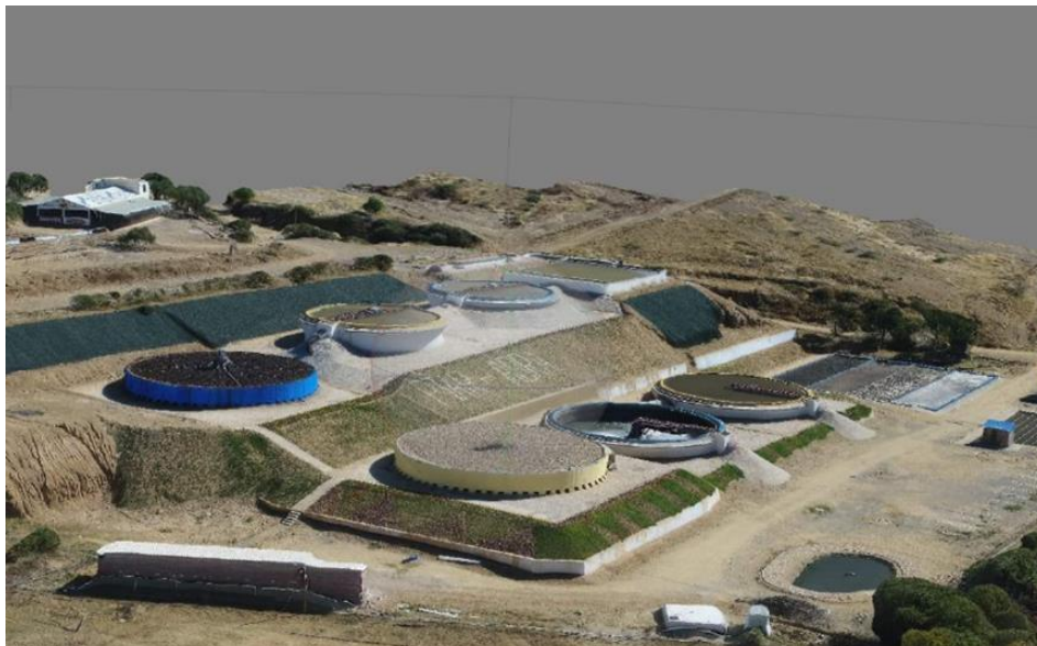
FIGURA No. 17 PTAR EL ABRA
